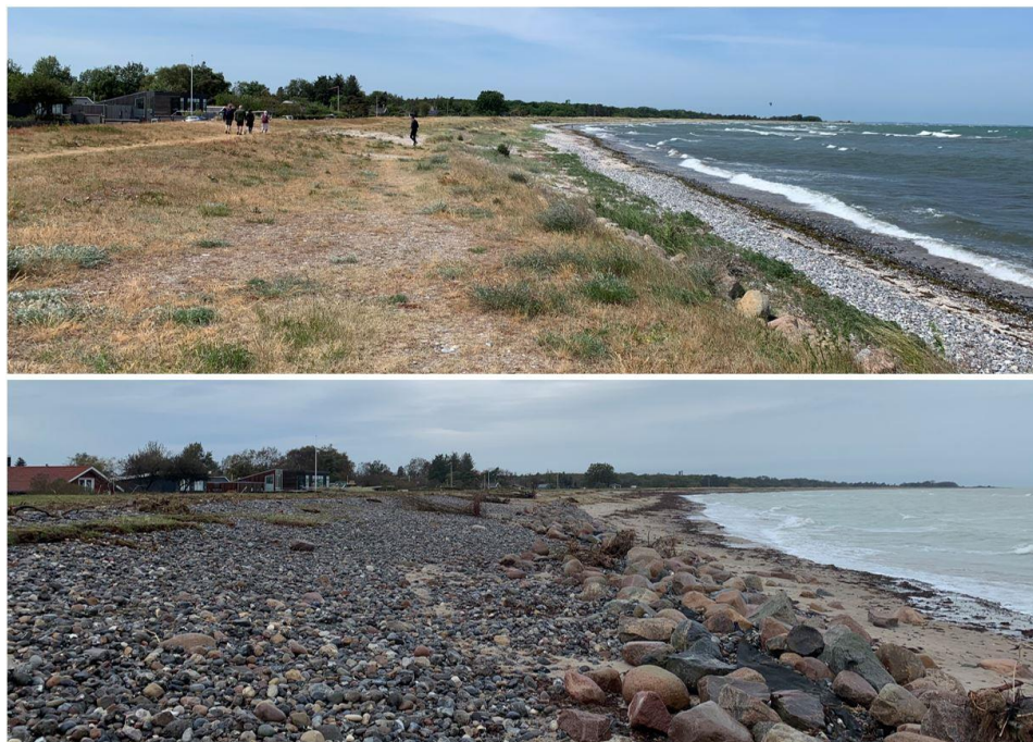
Figur 6 Ulvshalevej-området før (øvre) og efter (nedre) stormfloden. Store dele af plateauet er fjernet og stenkastningen er kollapsede mens ral er kastet op fra stranden til plateauet. Da diget mod vejen stadig er intakt, er skadesniveauet defineret gult.
