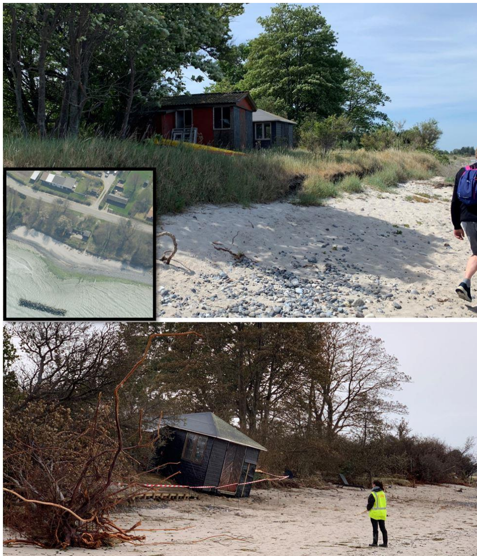
Figur 9 Stranden er allerede erosionspåvirket før (øvre) og særligt efter (nedre) stormfloden. Huset ligger nu på stranden og erosionen strækker sig under og på siderne af huset, så der nu kun er 13 m til Ulvshalevej, se flyfotoet.
