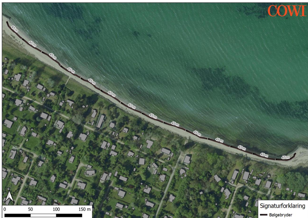
Figur 10: Position af stendepoter på land langs kysten i Ulvshale. Der kan etableres i alt 14 stendepoter af 45 m længde med 1 m mellemrum.
