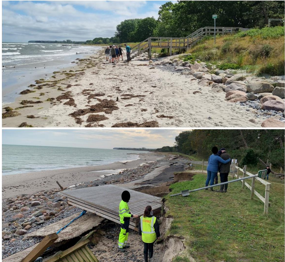
Figur 7 Strand og dige før (øvre) og efter (nedre) stormfloden. Skadesniveau rød for enden af Husmændenes Vej, hvor store dele af området er erosionspåvirket.
