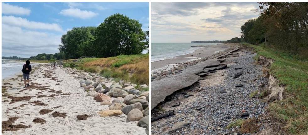
Figur 1: Digets tilstand før stormfloden (TV) og efter stormfloden (TH)
