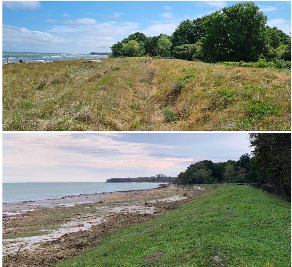
Figur 5 Østlige del af Nordre Dige før (øvre) og efter (nedre) stormfloden. Skadesniveau grøn bag bølgebryderne, sandfodringen og diget. Bemærk at havskarnslinjen ligger lige havværts digefoden
