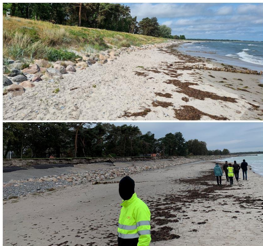
Figur 7 Strand og dige før (øvre) og efter (nedre) stormfloden. Skadesniveau rød for enden af Husmændenes Vej, hvor store dele af området er erosionspåvirket.
