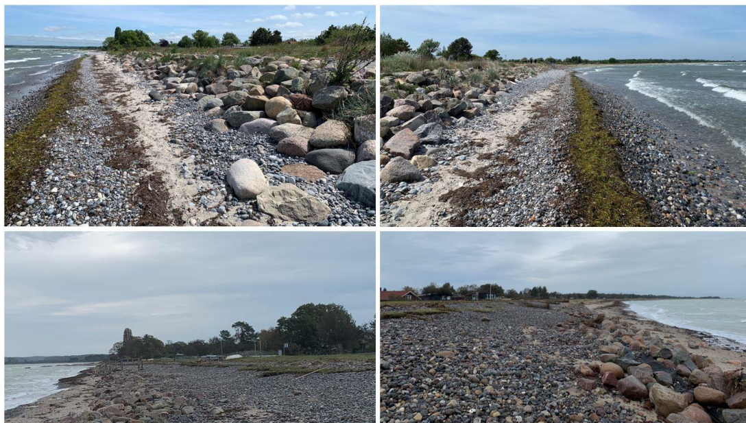
Figur 13: Stenkastning og strand før (øvre) og efter stormen (nedre). Stenkastningen er nu helt flad og bør genopbygges. Rallaget over hele plateauet bør flyttes tilbage til stenkastning og strand.
